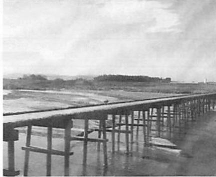
ありし日の「流れ橋」。時代劇のロケにたびたび使われている風情あふれる橋だー
